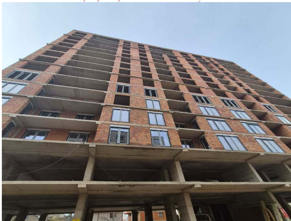
Foto 6. Gjendja e objektit 2B+P+14+PH me dy kate shtesë
